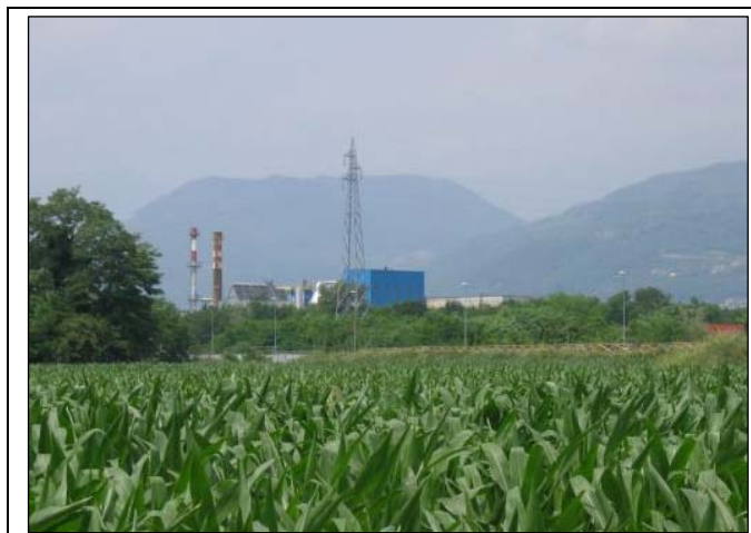
Vista dell'impianto da lato Sud (via Maestri del Lavoro) alla distanza di circa 400 m.
